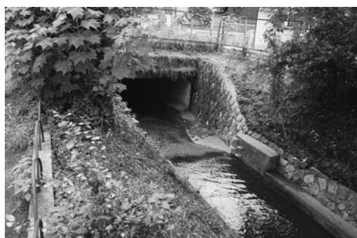
図 14 地下水路入口
