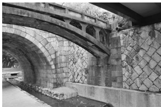
図 21 京都電気鉄道堀川線の橋脚跡
