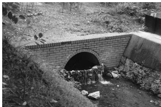
図 13 地下水路出口
