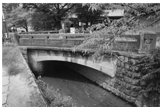
図7 銀閣寺への橋
