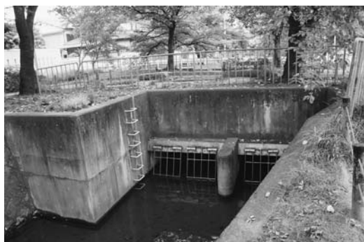
図 10 サイホン水路入口
