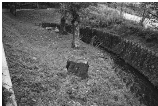
図2 疏水分線トンネル出口
