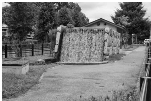
図 15 地下水路出口
