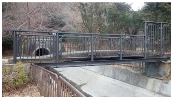
日本最古の鉄筋コンクリート橋側面
