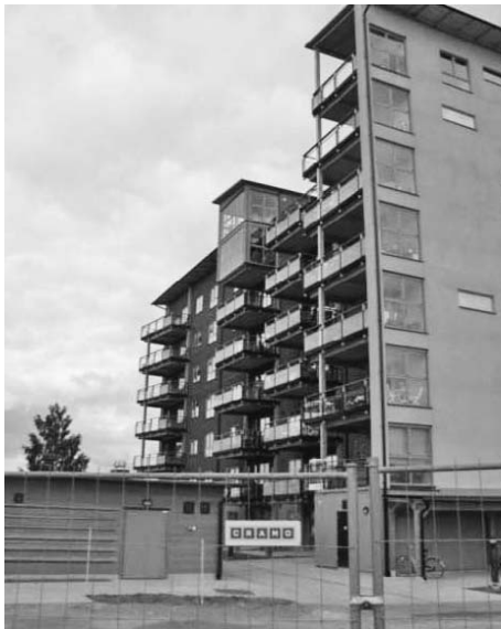
図 9 ベクショー大学の指導で建設中のほとんどが木製の集合住宅
