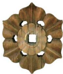
寺院屋根の側面の損傷した六葉
